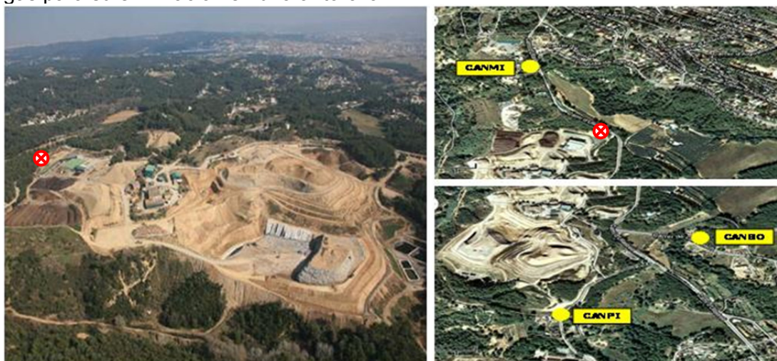
Figura 11. Localización de los puntos de control en el entorno del vertedero
